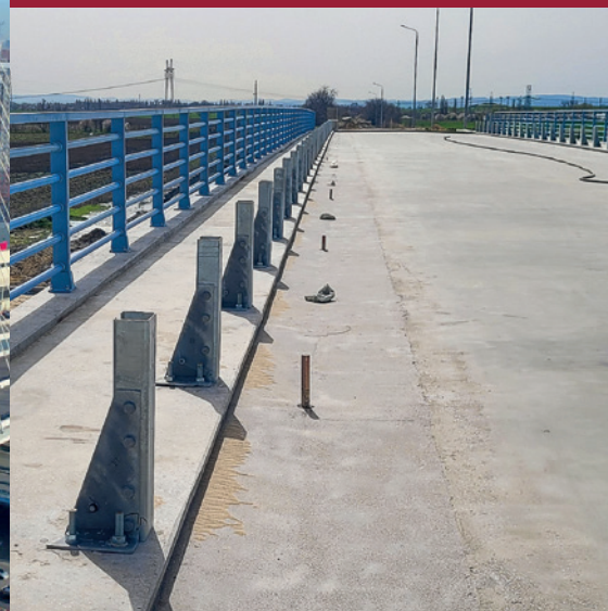
Федеральная автомобильная дорога А-289 КРЕПЛЕНИЕ ШУМОЗАЩИТНЫХ ЭКРАНОВ, БАРЬЕРНЫХ ОГРАЖДЕНИЙ, ВОДООТВОДА
