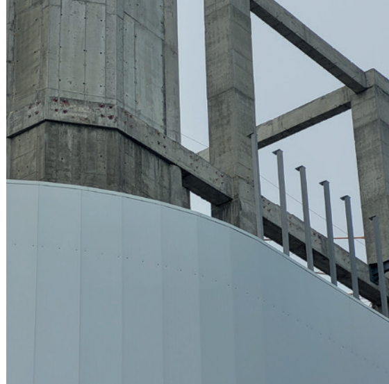
Торговый центр «Пирамида», г. Волгоград КРЕПЛЕНИЕ МЕТАЛЛОКОНСТРУКЦИЙ ДЛЯ СЭНДВИЧ-ПАНЕЛЕЙ
